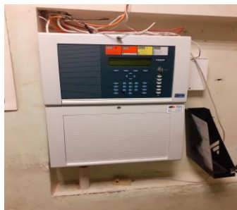
1. attēls. UATS kontrolpanelis 1.stāvā pie galvenās ieejas durvīm.
