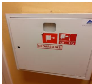
6. attēls. Iekšējā ugunsdzēsības ūdensvada krānu kaste.
